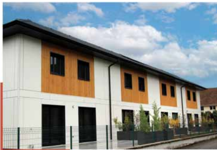
Logements modulaires livrés prêts-à-vivre à Vallières (74)
